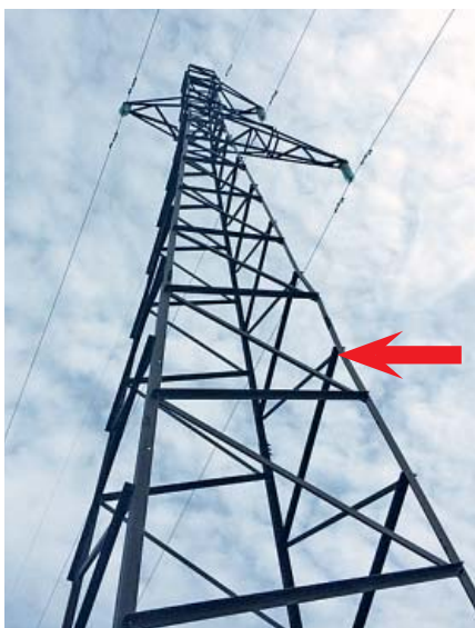
Рис. 9. Место стыковки первого и второго поясов
